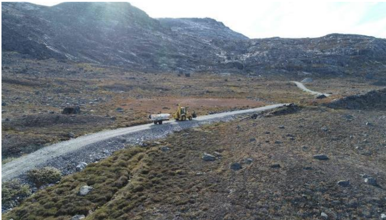
Figur 18: Eksempel på eksisterende arbejdsvej ved Buksefjordsværket.
