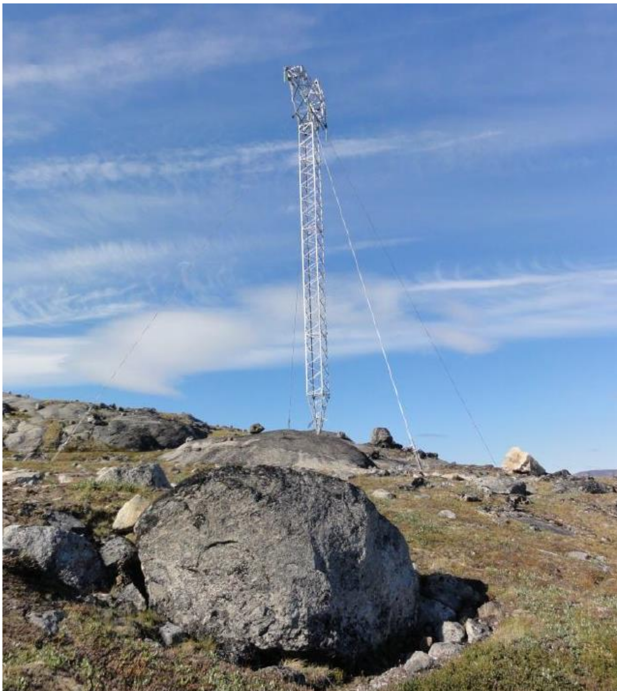
Figur 21: Eksempel på gittermast fra Ilulissat vandkraftværk.
