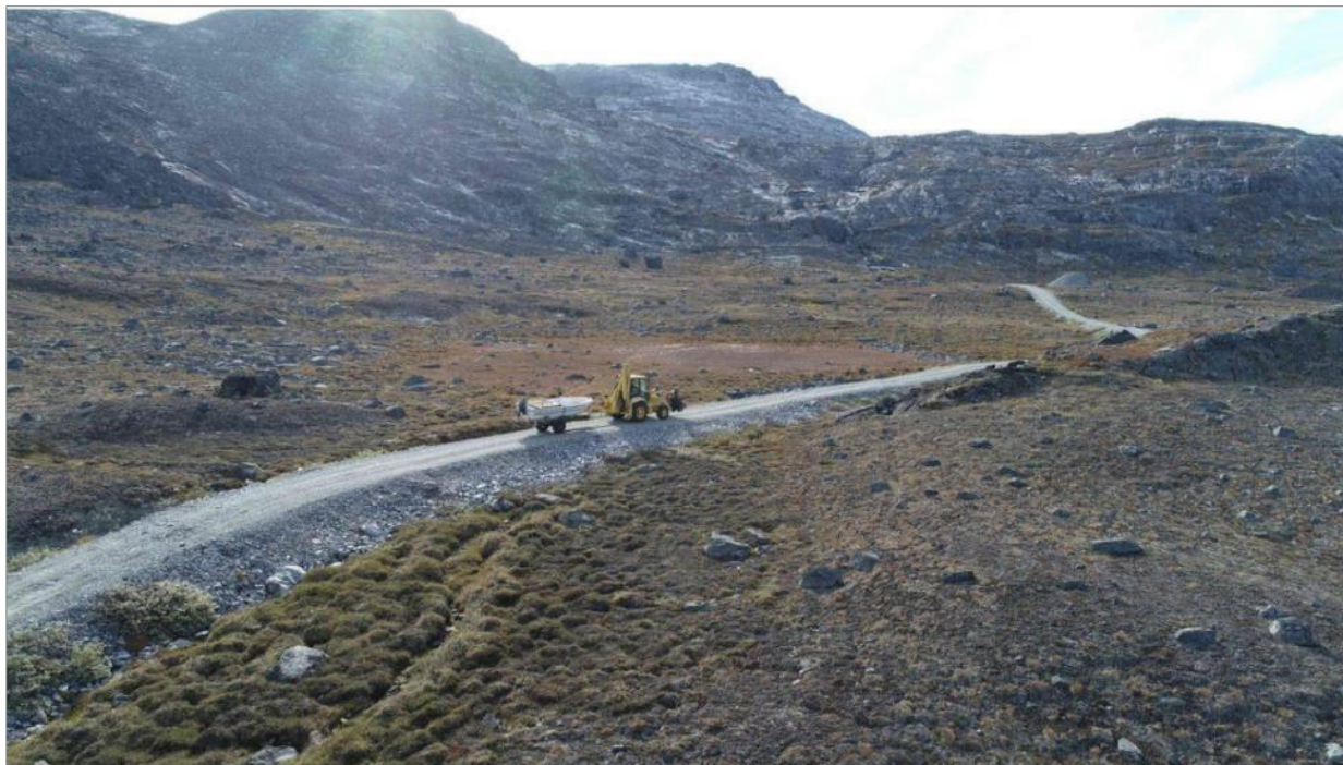
Figur 79: Eksempel på grusvej gennem terræn (2022 - en adgangsvej relateret til Buksefjord vandkraftanlæg).
