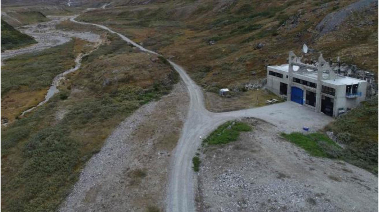
Figur 15: Foto af indgangsportalen ved den eksisterende kraftstation.
