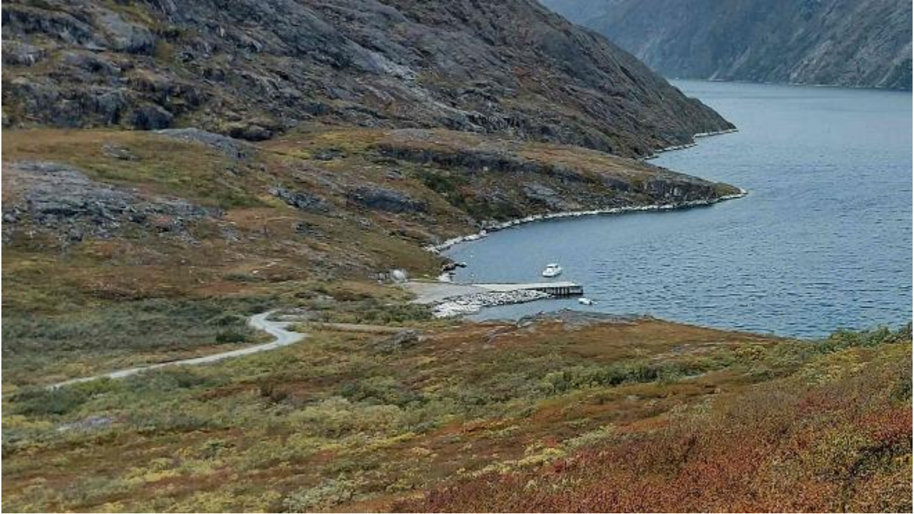
Figur 17: Foto af den eksisterende kutterkaj ved Buksefjorden
