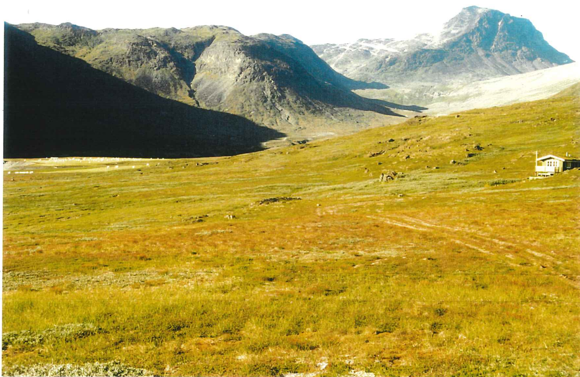
9849 Langs mulig råvandsledning fra Taseq-søen mod nord.
