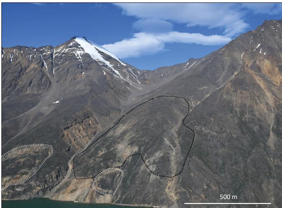
Figur 11: Det ustabile fjeldparti Kigarsima. Den sorte stiplede linje viser omfanget af det ustabile område kortlagt ud fra InSAR. Bagvæggen, dvs. den øvre afgrænsning, af Kigarsima ligger i 650 m højde. Bemærk at der også neden for det store ustabile område og på den modsatte side af kløften er to mindre områder i bevægelse (markeret med grå stiplede omrids), som dog vurderes at have volumener, der er for små til at kunne forårsage en markant tsunami.
